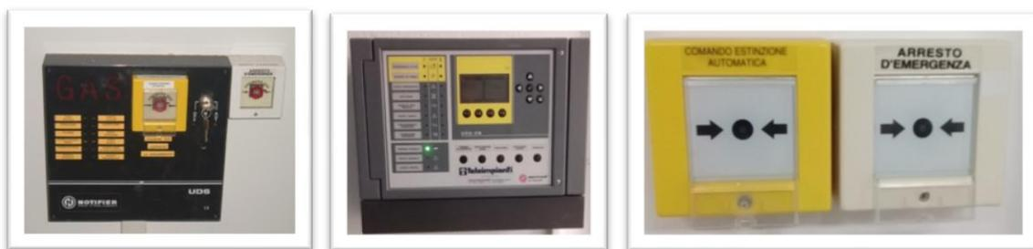
Circa 4 secondi dopo avere premuto il pulsante **giallo** di "estinzione automatica", si innesca la scarica immediata del gas inerte. La procedura non può essere interrotta, nemmeno premendo il pulsante **bianco** di "arresto d'emergenza"; è possibile inibire la scarica solo ed esclusivamente con la chiave dell'Unità Di Spegnimento - UDS in posizione "Off" entro i 4 secondi.
